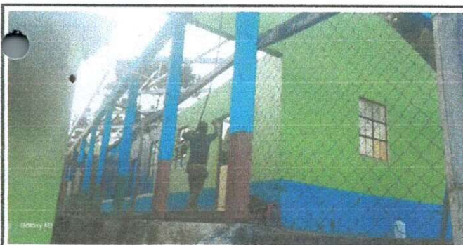
Foto 5: Cambio de techo de las aulas, módulo 1.
